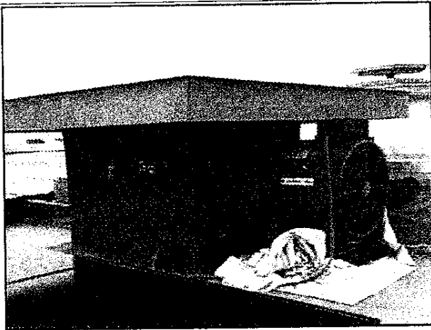
写真: 仮設の換気装置
