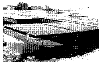
▲メディアコスモス屋上の水溜り。 太陽光パネル下黒くみえるのは全て雨水。
